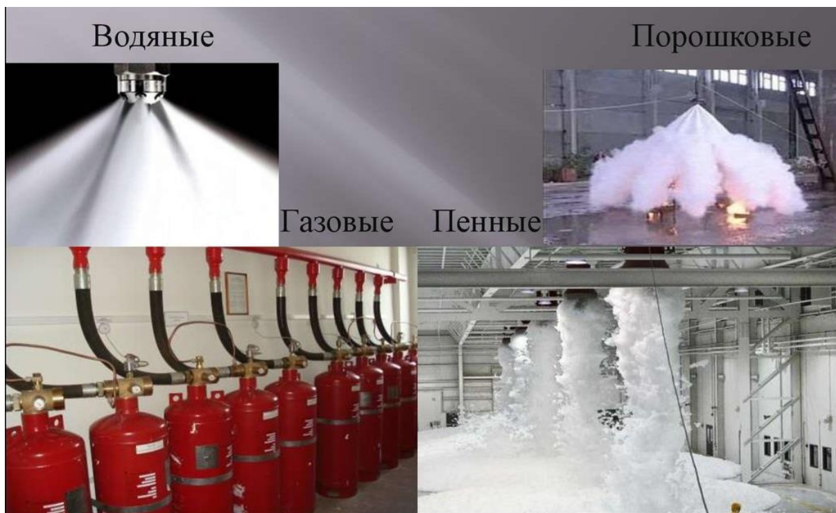
Рис. 20. Некоторые виды автоматических установок пожаротушения
